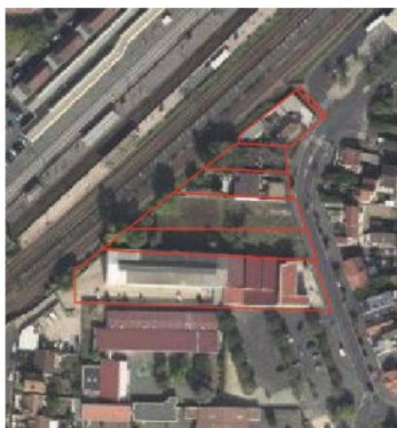
PHOTO AERIENNE DE L'OAP N°1 Source : Géoportail
